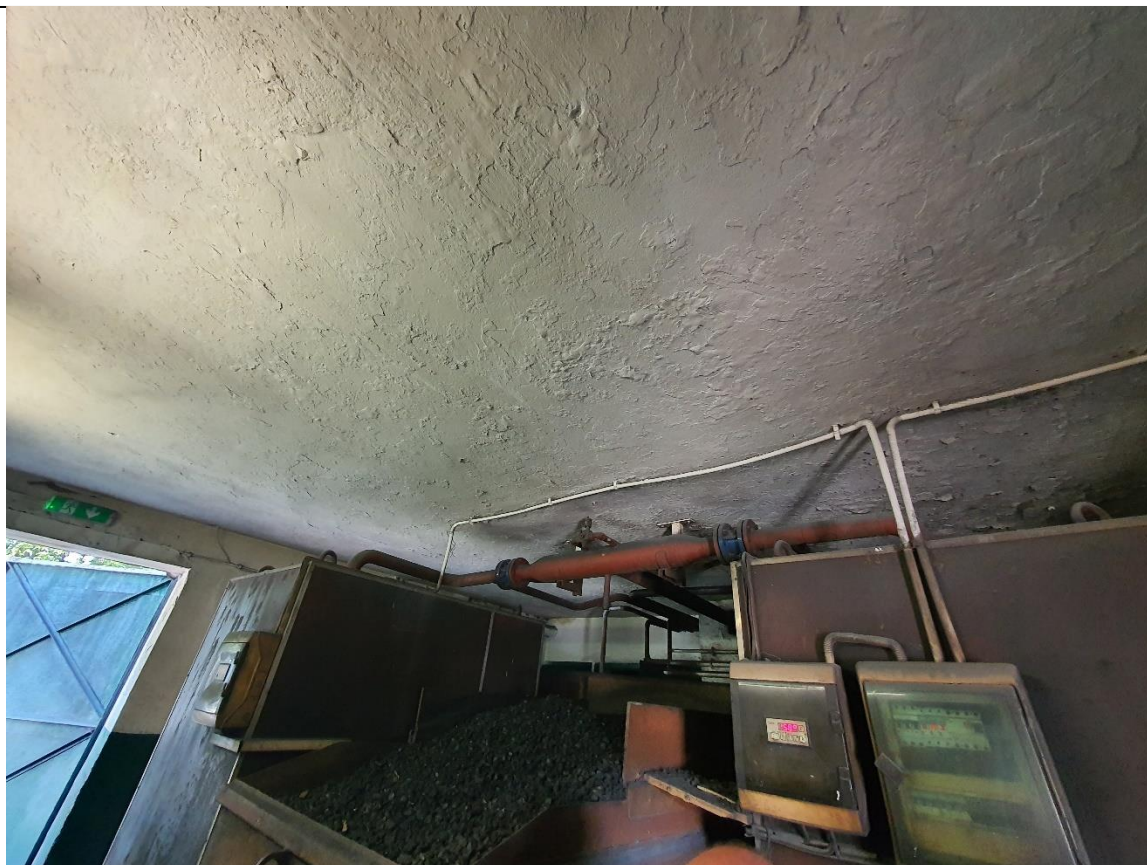
Rys. 2. Istniejące kotły węglowe
